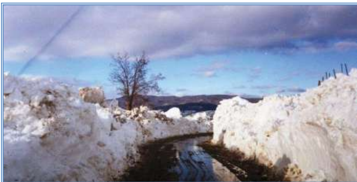
SP 47 Strada di accesso alla Diga Ancipa Progr.va Km.ca 2+000 circa loc. Troina
