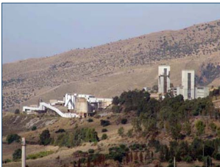
L'AREA DI MONTE PASQUASIA E L'IMPIANTO MINERARO
