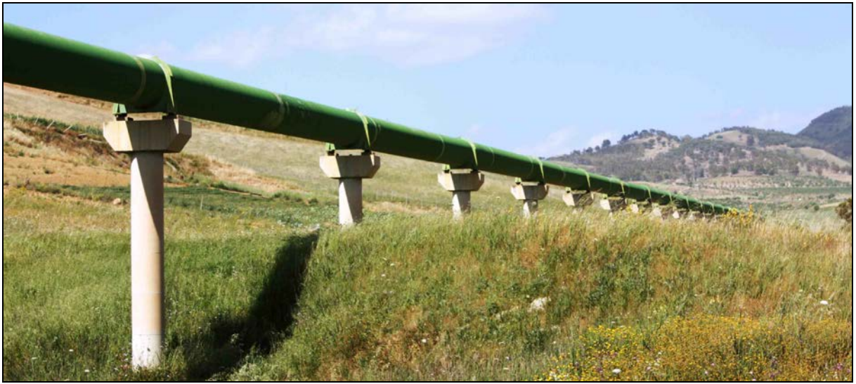
Foto 5 – Acquedotto a valle della Diga Olivo
