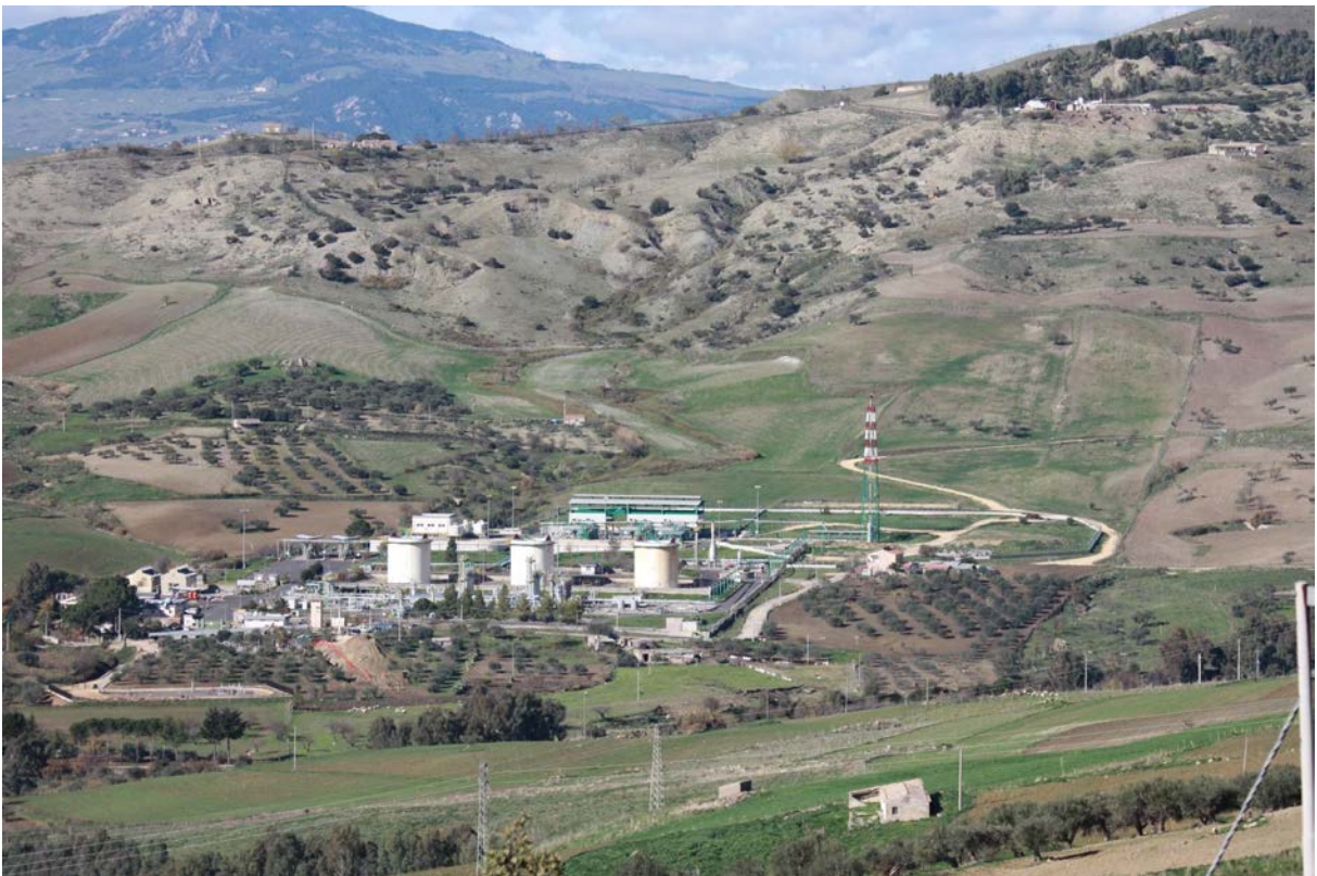
Foto 11 – Centrale di stoccaggio gas naturale EniMed di Gagliano Castelferrato.
