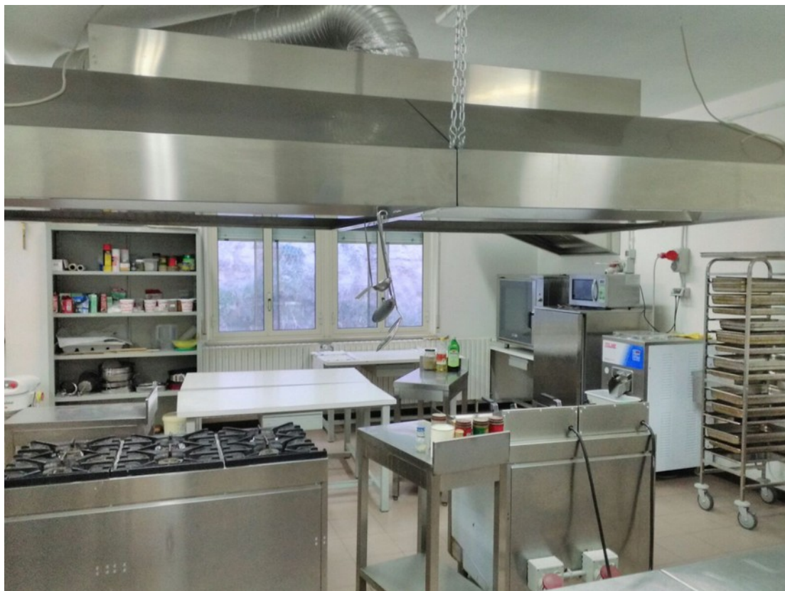
Veduta interna – cucine
