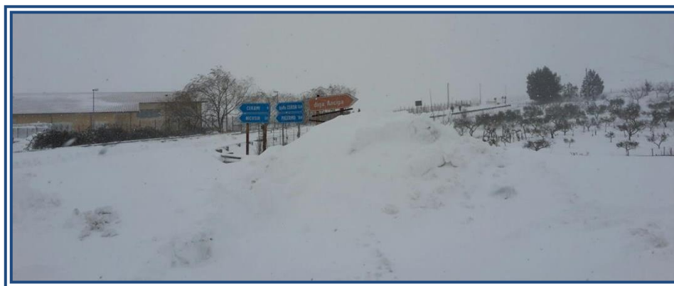
Fig. 1 - ( Anno 2019) SP 47 Strada di accesso alla Diga Ancipa
